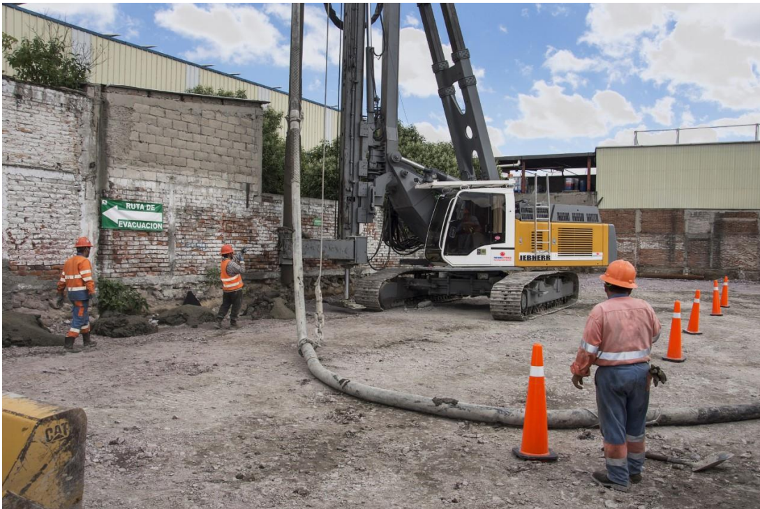
Instalación de Columnas de Módulo Controlado con barrena de desplazamiento en CEDIS, Ciudad de México.
