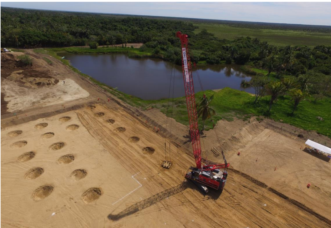
Aplicación de la técnica de Compactación Dinámica (CD). Municipio de Cárdenas, Tabasco.
