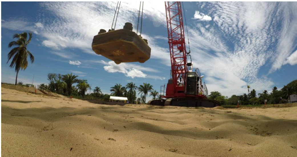
Fotografía de la masa de Compactación Dinámica (CD).
