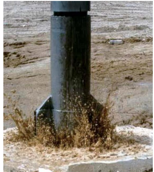
Figura 2. Aplicación de la Vibrocompactación.
