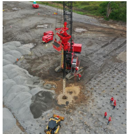
Figura 1. Aplicación de Columnas de Grava, Vía Seca.
