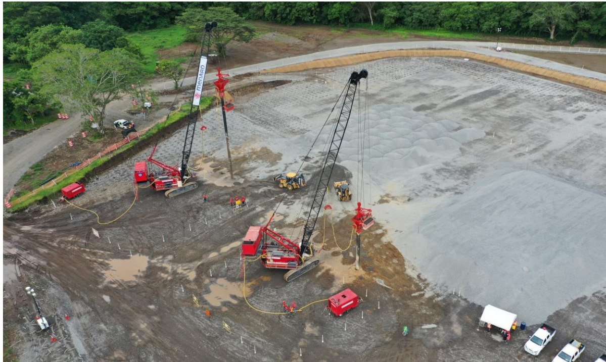
Aplicación de la técnica de Columnas de Grava para una PTAR.
