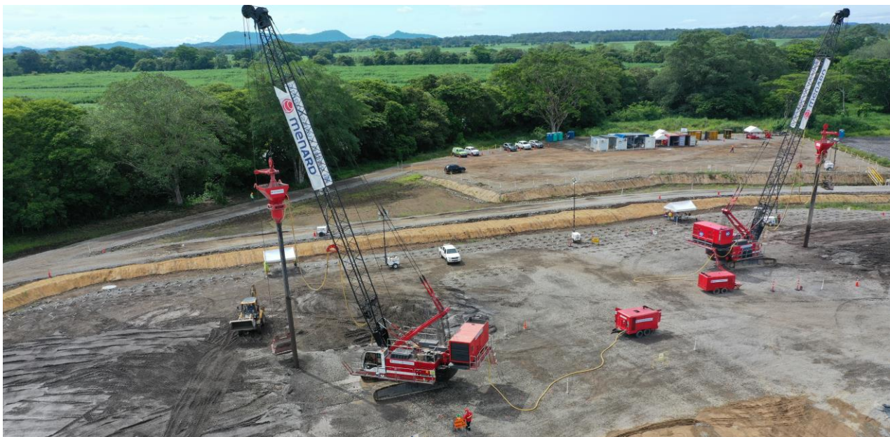
Figura 5. Construcción de Columnas de Grava en PTAR.
