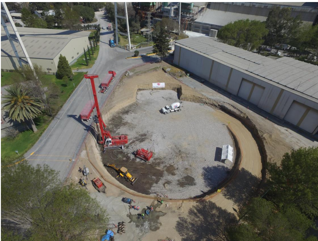
Figura 3. Instalación de Columnas de Módulo Controlado (CMC).
