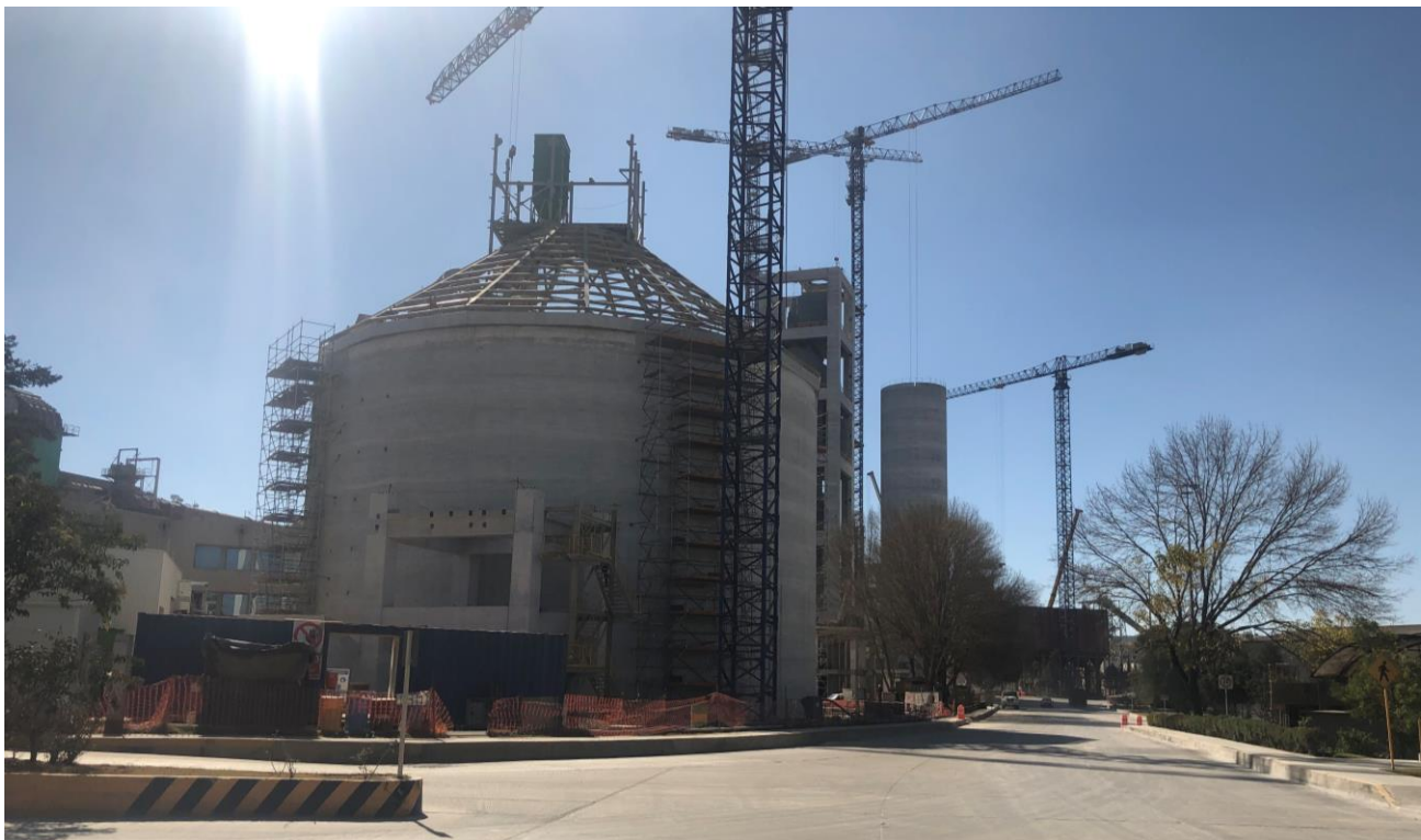
Silo de Clinker cimentado con mejoramiento de suelos.
