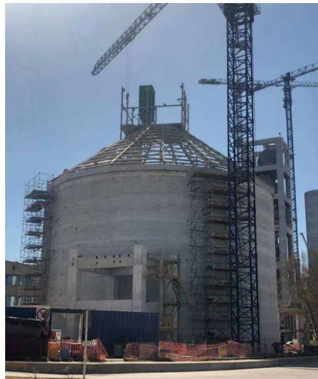
Figura 2. Silo de Clinker cimentado con CMC.
