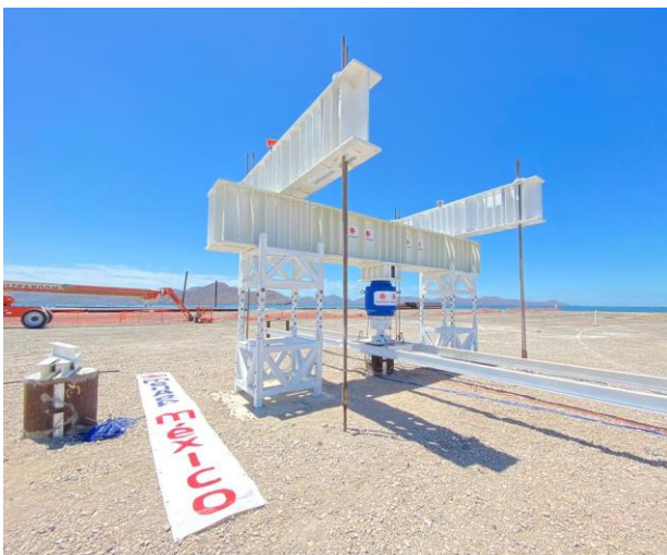
Figura 3. Pruebas de carga estática a compresión (a la falla) por medio de un marco de reacción en Columnas de Módulo Controlado (CMC)
