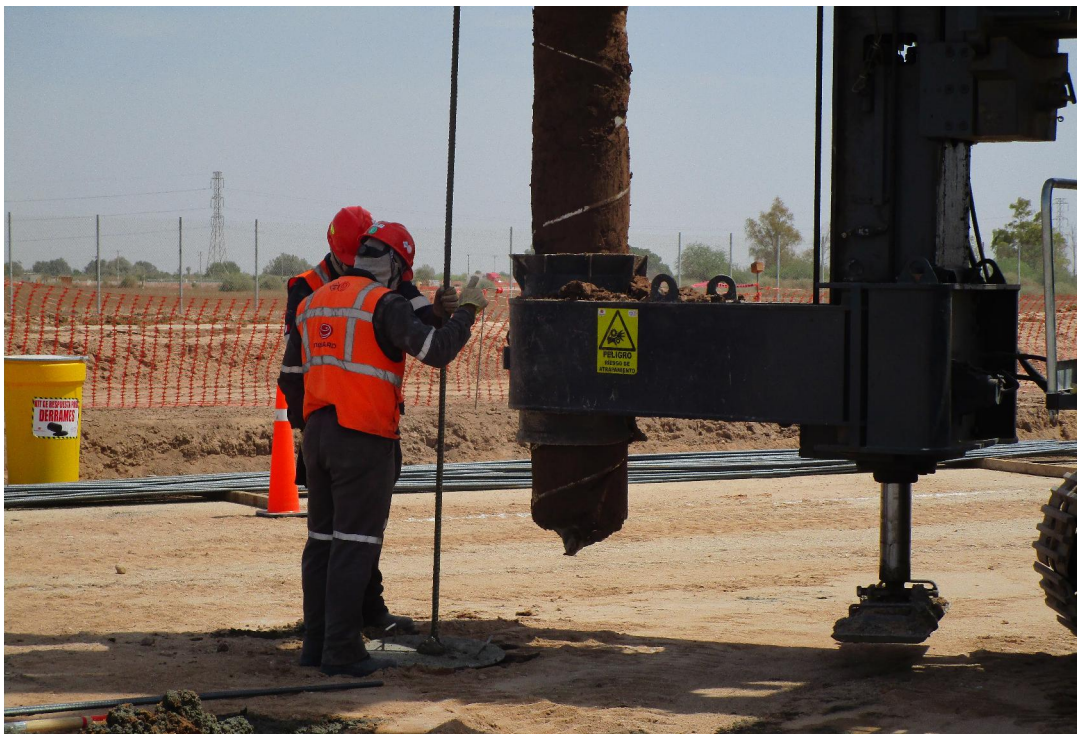
Colocación de acero de refuerzo en Inclusión de Concreto tipo Columna de Módulo Controlado (CMC). Mexicali, B.C., México.
