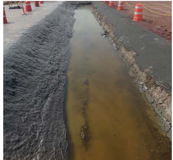
Figura 5. Vista de la membrana y la zanja de estanqueidad perimetral. La depresión causada por las bombas de vacío, es evidente cuando la membrana tiende a “pegarse” al suelo que cubre.
