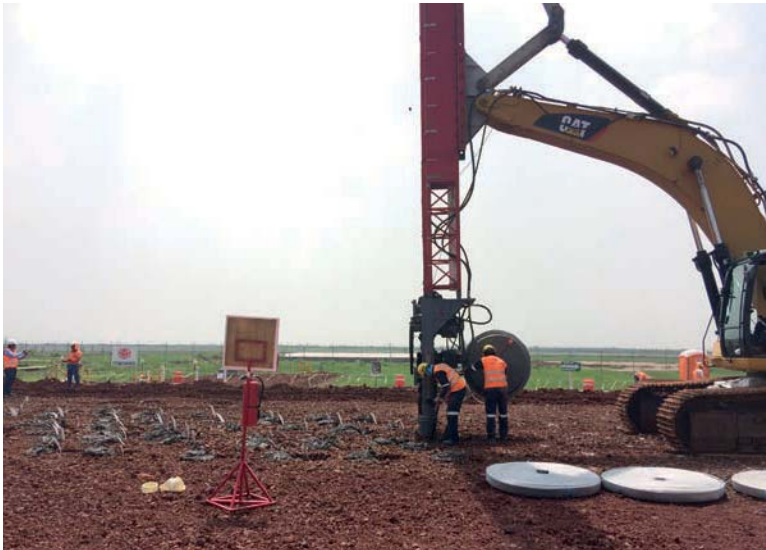
Figura 4. Vista de la máquina utilizada para la instalación de los Drenes Verticales Prefabricados (DVP) para acelerar el proceso de consolidación.
