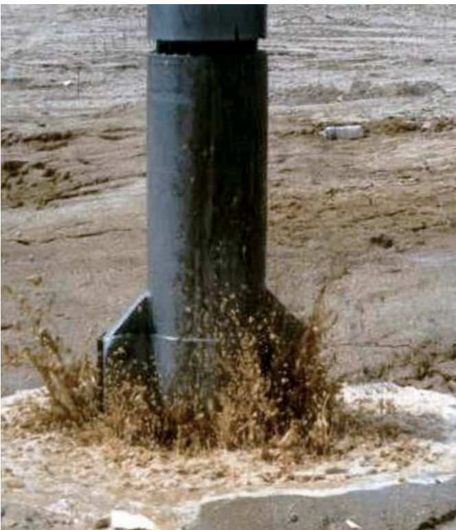
Sonda vibratoria en la fase de extracción.
