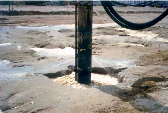
Penetración de la sonda vibratoria con inyección de agua
